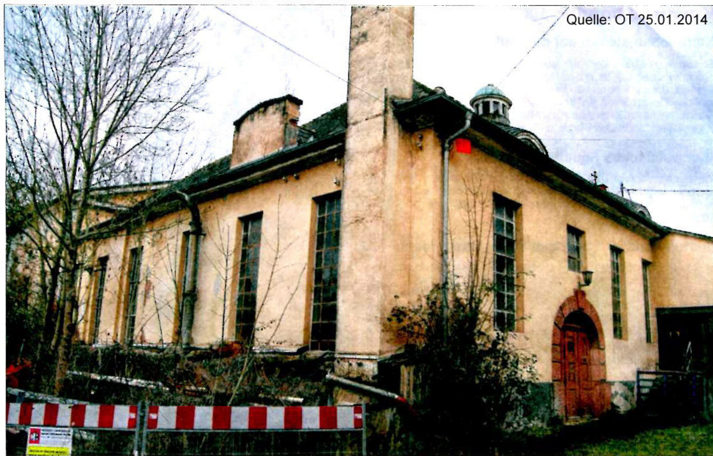
Am ehemaligen Maschinen- und Turbinenhaus der einstigen Zündholzfabrik Bauer und Schönenberger in Haslachs Stadtteil Schnellingen nagt der Zahn der Zeit.
